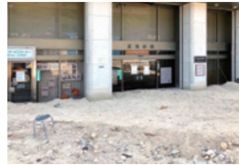
支店に堆積した土砂(安芸郡坂町)
