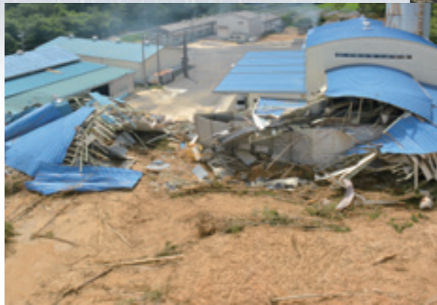
倒壊した共同利用施設や農業倉庫(三原市大和町)
